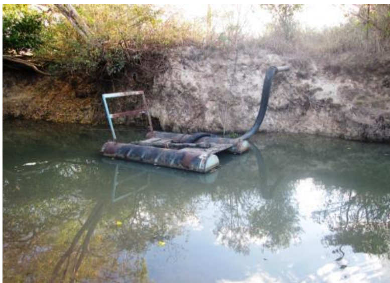
FIGURA 3 – SISTEMA DE CAPTAÇÃO FLUTUANTE DE MUNDO NOVO
